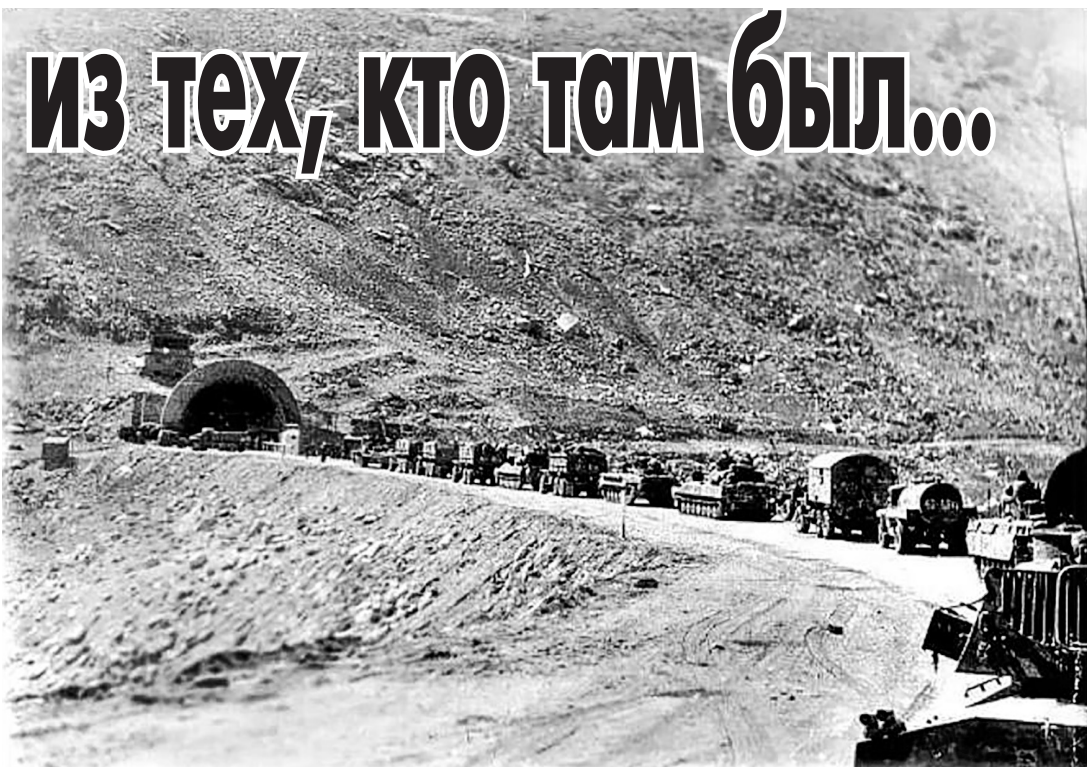
Наша колонна на перевале Саланг у входа в тоннель. Длина его с каскадами галерей - 4 километра.
